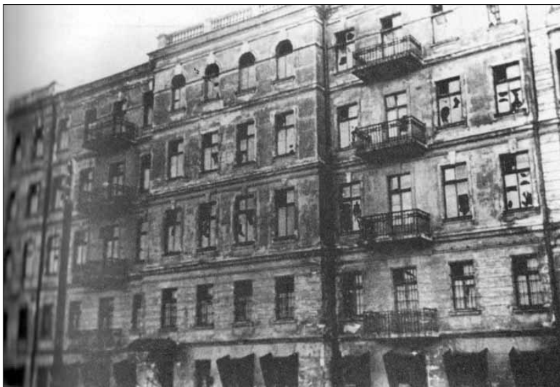
Одесса. Развалины здания ЧК после взрыва. Внутренний корпус. Фото 1941 г.
