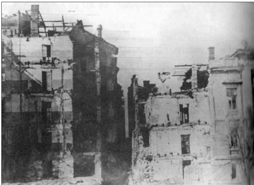
Одесса. Развалины здания ЧК после взрыва. Фасад. Фото 1941 г.
