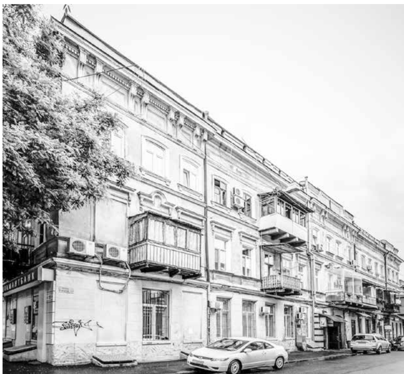
Длинный трехэтажный жилой дом (архитекторы С.А. Ландесман и В.И. Кундерт) со старинными каменными тумбами по обе стороны ворот, чугунными винтовыми лестницами в парадных да небольшим квадратным двором.
