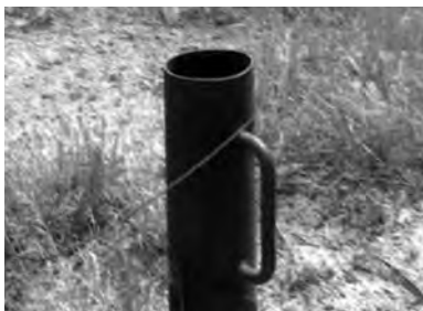
Вентиляционная труба погреба, сделанная из части трубчатой станины немецкой пушки Кадр из видеосъемки автора. 31 июля 2007 г.
