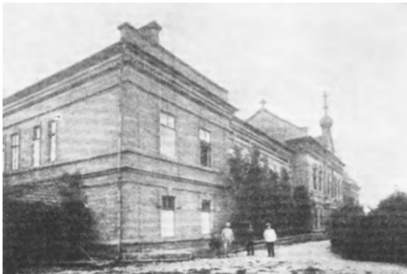
Фасад здания приюта
